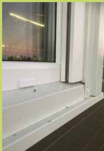
Utvendig omramingsbeslag for sandwichelement.
