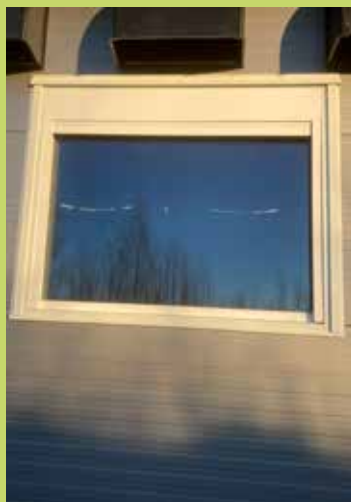
Rullgardinvindu med omramingsprofil montert i sandwichelement.
